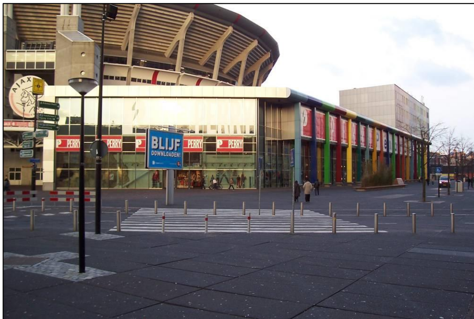
Slecht vormgegeven publieke ruimtes zonder sociale veiligheid, Blijkbaar alleen ontworpen voor voetbalfans van en naar het stadion.
